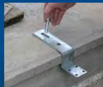
aanbrengen bevestigingsmiddelen
