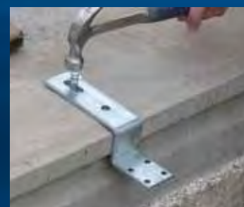
aanbrengen bevestigingsmiddelen
