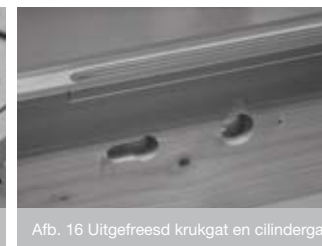
Afb. 15 Uitfreesen krukgat en cilindergat
